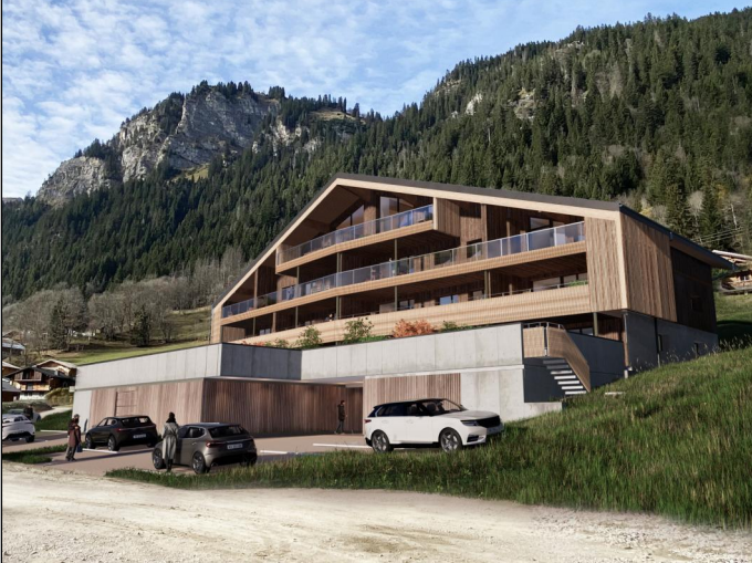
Vue façade Sud
